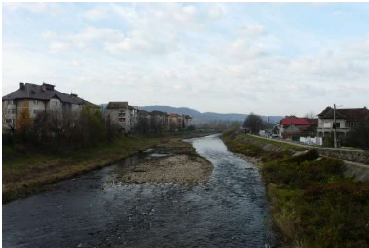
Foto 6 – Lucrari de regularizare (diguri) ale albiei pe râul Sebeș
