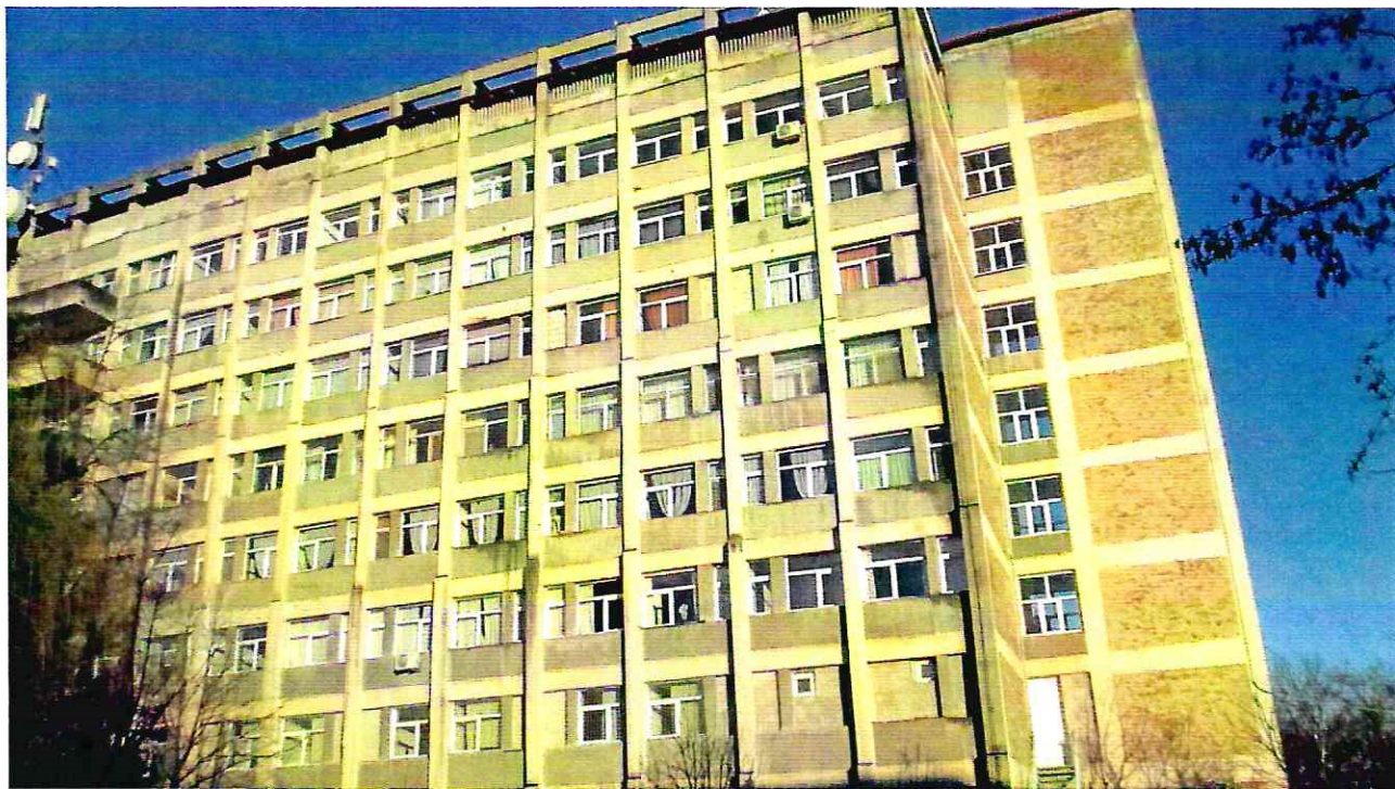
FOTO nr. 02 - Fațadă NORD.
