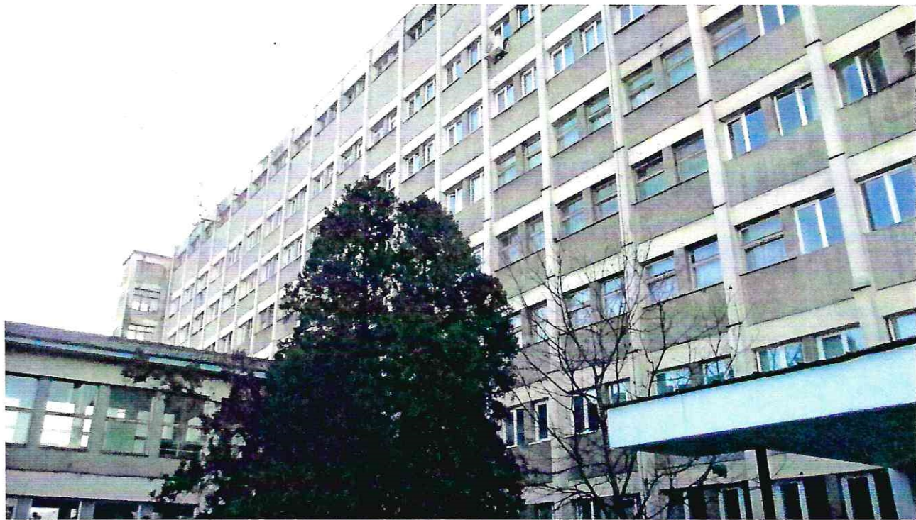
FOTO nr. 01 - Fațadă SUD.
