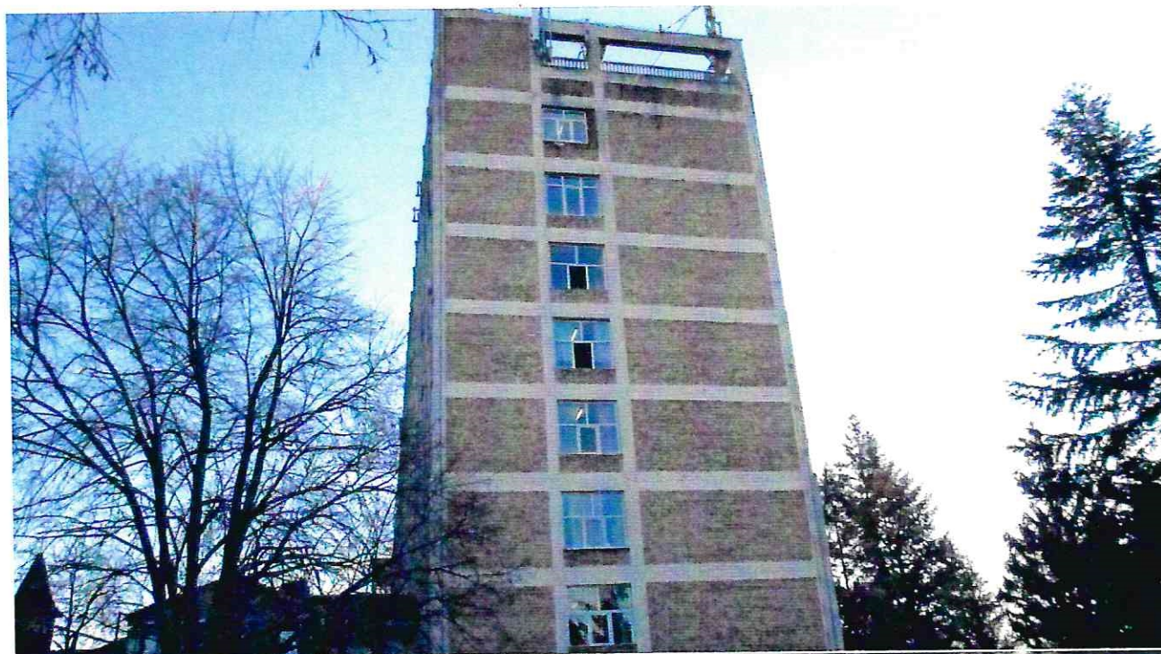
FOTO nr. 04 - Fațadă EST.
