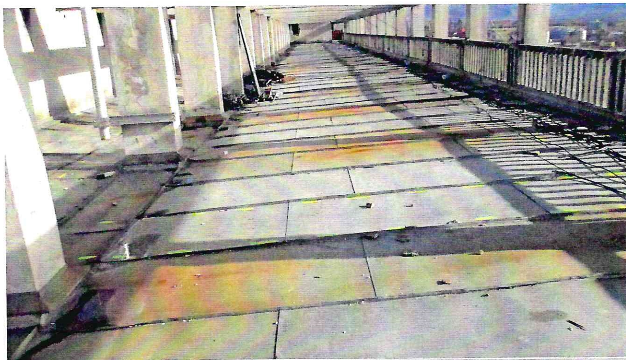
FOTO nr. 17 - Parapet traforat ax Z.
